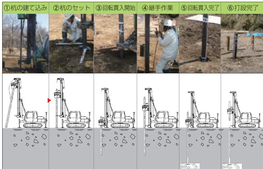
① 杭を吊り込んで杭先端を杭芯に合わせる。
