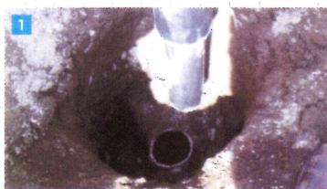
杭頭打撃用治具設置
